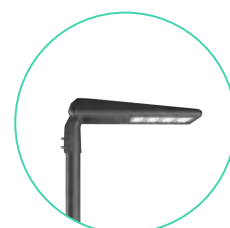
Instalación en columna
